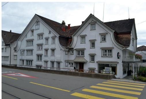
Rückfassade zum Strassenraum: Die Treppenhäuser sind durch die versetzten Fenster in der Mitte des Gebäudes erkennbar.
