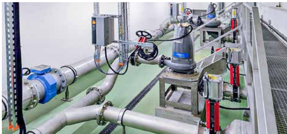
Der fertige Rohrkeller ↑
