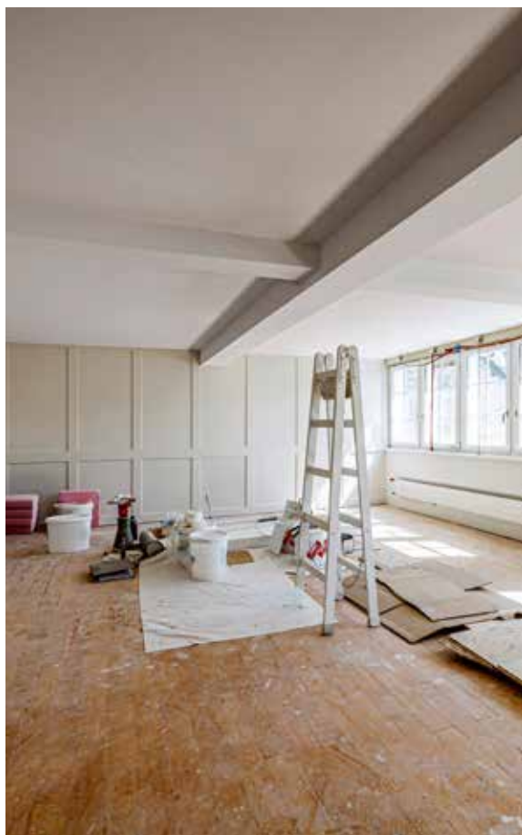
Sanierung «Haus Bächli» ↑
